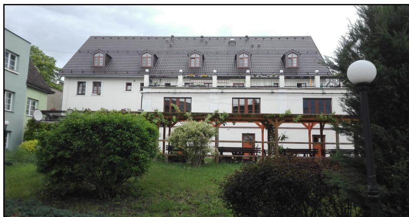
Nová střecha na budově DPS Žižkova
